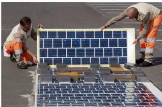
Magry-les-Hameaux (Yvelines), septembre 2015. Alors que les cellules photovoltaïques sont réputées très fragiles, la société Colas a réussi à concevoir des dalles résistantes à la circulation qui se posent sans travaux préalables. (Colas/Jaohim Berthand)
